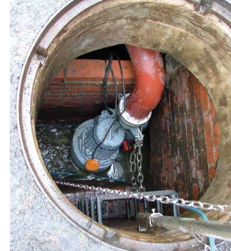
Reparaturarbeiten in einem Kanalschacht: Auch das gehört zu den Aufgaben des Zentralen kommunalen Entsorgungsbetriebs (ZKE) Saarbrücken.
